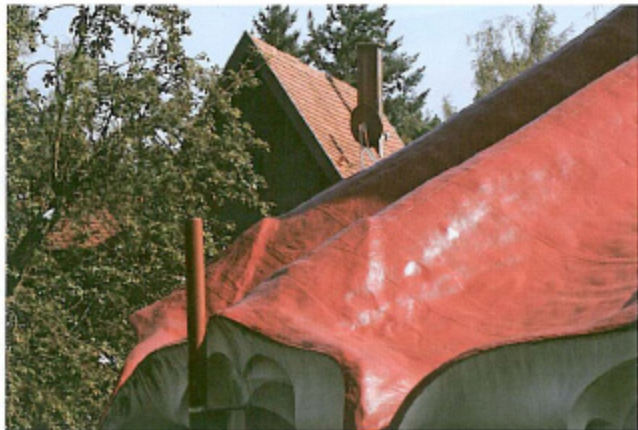
Kemperol znakomicie dopasowuje się do nieregularnych kształtów dachu
